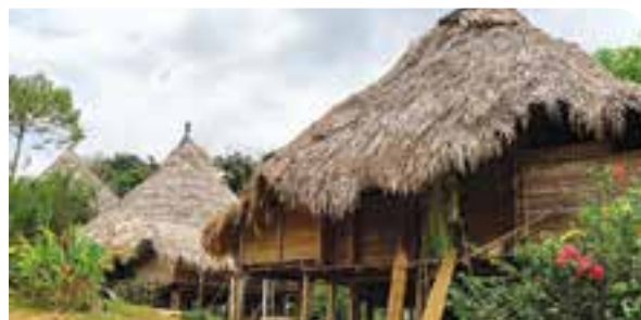
Debido al caudal de los ríos, muchas construcciones se realizan sobre postes o palafitos.
